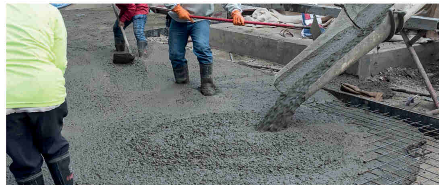
Sopra: Il BIM ha bisogno di una struttura e di una guida - come il calcestruzzo che viene versato in una lastra.
